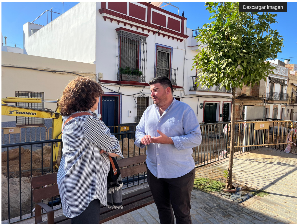
Inicio de la obra de calle Pizarro
